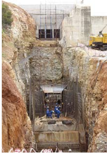
Fig. 3: Sol Plaatje Powerhouse construction.
